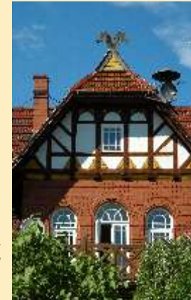
Zwerchgiebel aus Fachwerk mit Holzbalkon und Pferdeköpfen in Dörnte (erbaut 1912): Heimat- und Schweizerhaus-Stil waren eine Reaktion auf die Kritik an den "Backsteinkästen".
