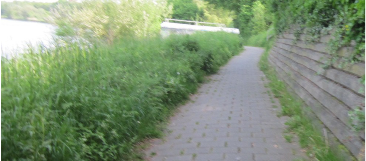
Bild 26: Zu schmaler bzw. zugewucherter Radweg. Mindestbreite für Zweirichtungsweg 3,00 m (2,50 m), für Einrichtungsweg 2,00 m (1,60 m) / Werte in Klammern jew. bei geringer Verkehrsstärke. Pflege des Seitenraumes ggf. anmahnen
