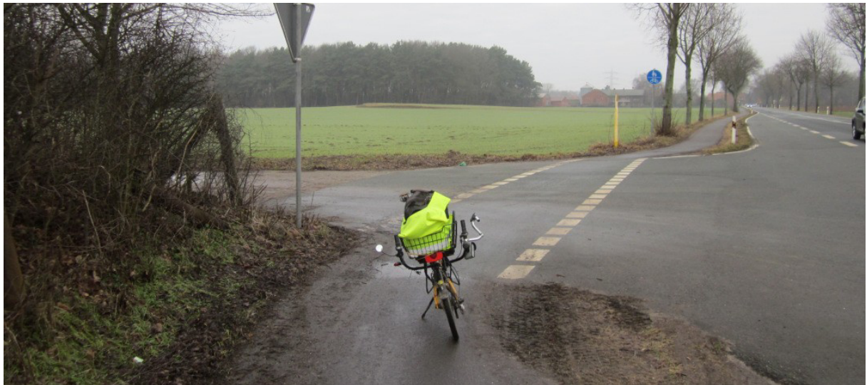
Bild 20: Unübersichtliche Einmündung/Ausfahrt für Rad- und Autofahrer. Hier ist dringend der Bewuchs zurückzuschneiden. Bei einer Sanierung des Radweges sollte die Verschwenkung an der Ausfahrt aufgehoben werden.
