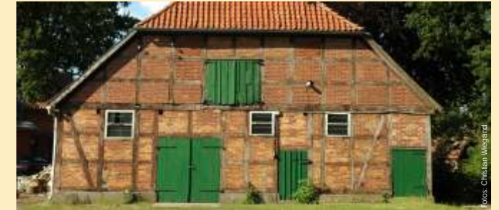
Umgebautes Vierständerhaus an der Ringstraße in Bohlsen
